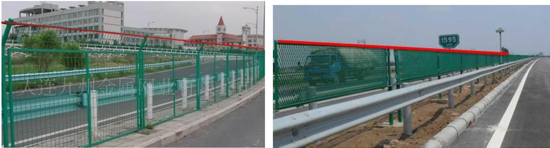
图 23 防护网（制作在防护网可见的顶部位置）
